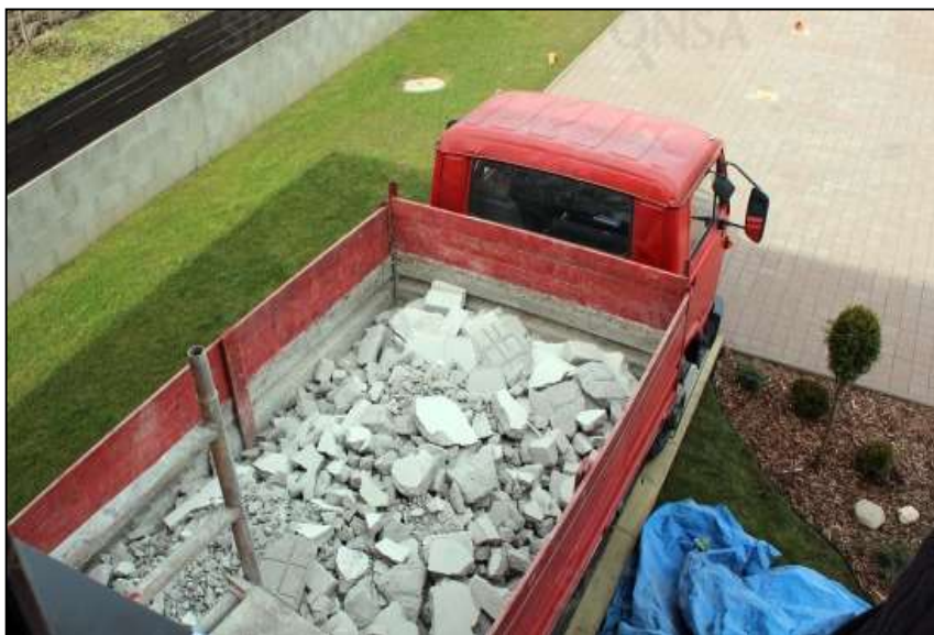
5. 13. Ábra Építési és bontási hulladék gyűjtése.
