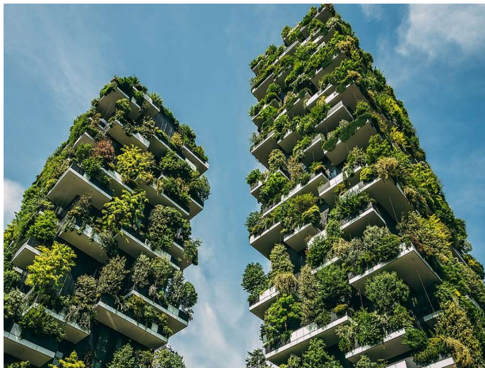
1. 2. Ábra Egy példa a zöld épületre Olaszországban (Milánó) (Függőleges erdő)
