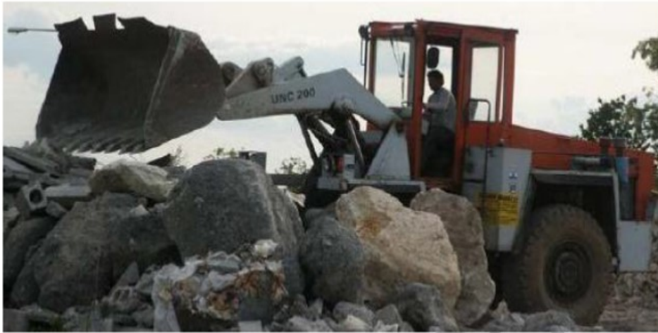
Pav. 3. 18. Didelio pajėgumo ekskavatorius statybinėse nuolaužose
