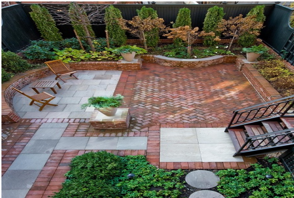
Pav. 3. 40. Apdirbtas plytinių grindų paviršius.
