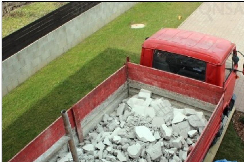
Pav. 5. 13. Statybos ir griovimo atliekų surinkimas.
