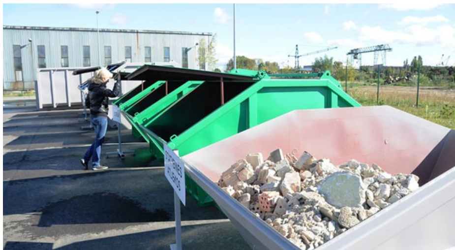
Pav. 5. 15. Statybos ir griovimo atliekų rūšiavimas statybų aikštelėje.
