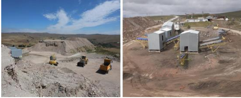
Şekil 4. 4. Eskişehir Büyükşehir Belediyesi geri dönüşüm tesisi.
