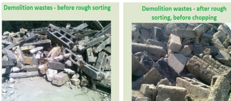
Şekil 3. 17. Yıkıntı atıklarının ayıklanması.
