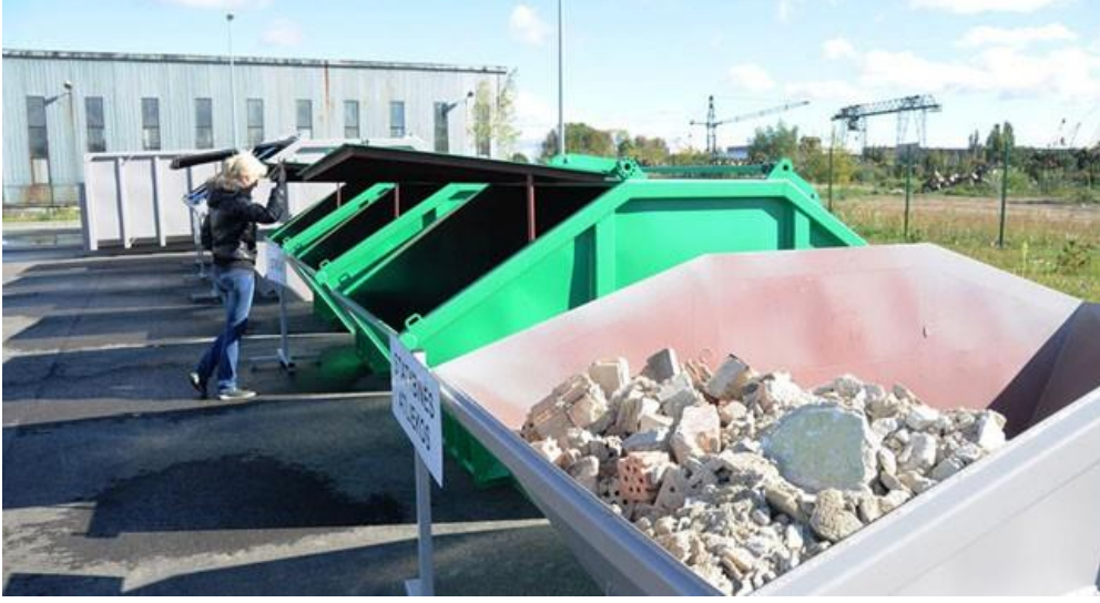
Şekil 5. 15. İnşaat ve yıkıntı atıklarının yerinde ayrılması.
