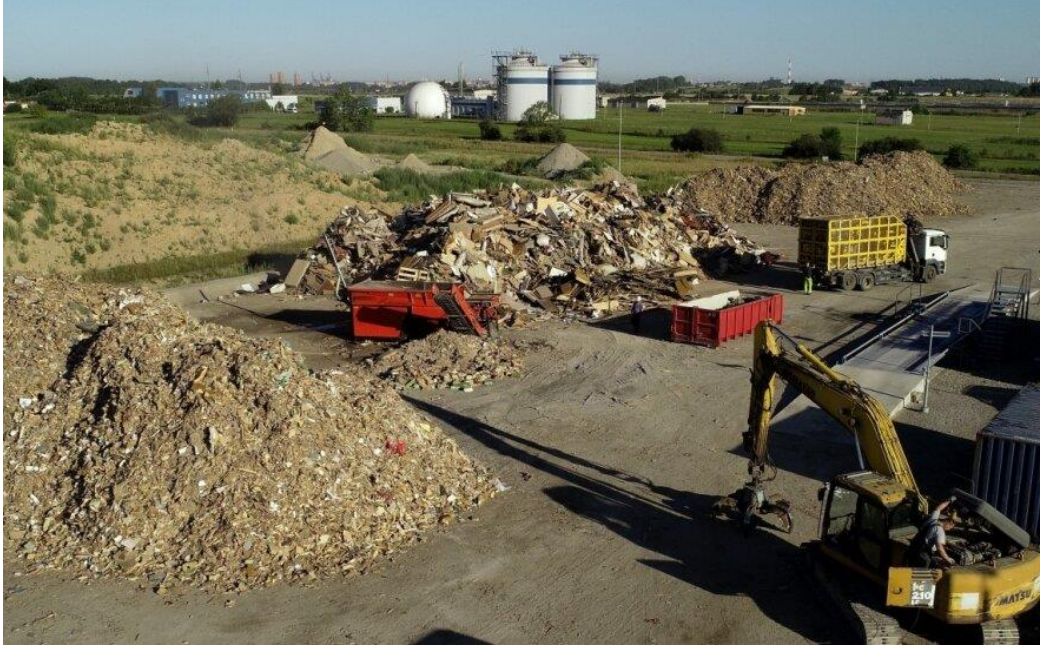
Şekil 5. 14. İnşaat yıkıntı ayıklarının ayıklanması.
