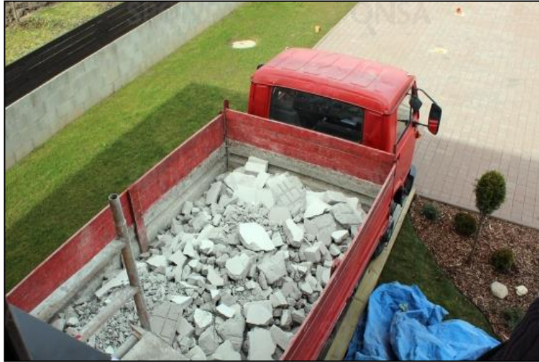
Şekil 5. 13. İnşaat yıkıntı atıklarının toplanması.
