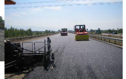
Geri dönüştürülen asfalt kaplama İSTAÇ Bolluca Güzergahı
